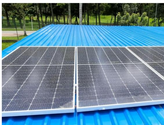
En total, 48m2 de paneles solares, generan la energía para el funcionamiento de los equipos electrónicos y cuatro reflectores solares suministran iluminación perimetral al campamento y alumbrado externo.
