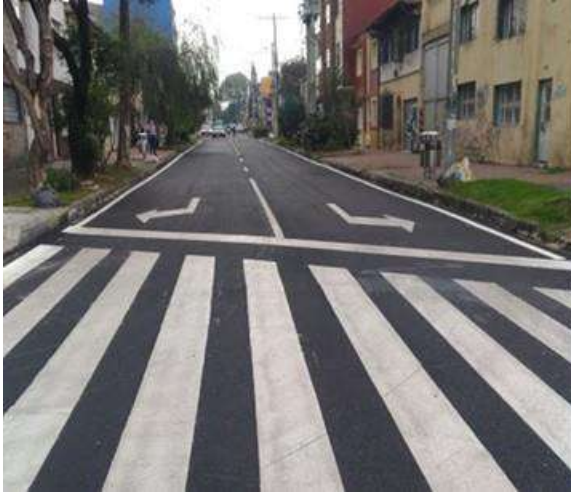
Foto: Vía terminada con señalización
